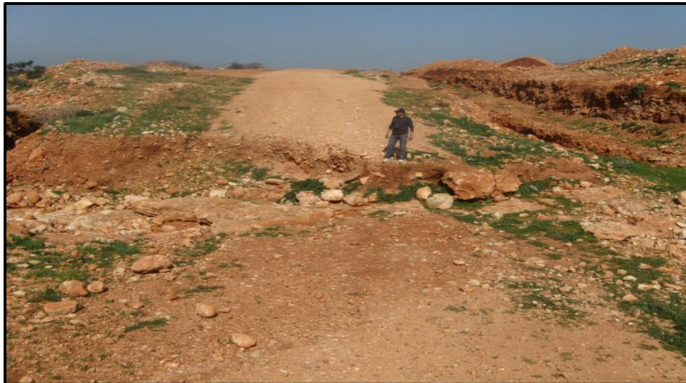
(الصورة-4) : تدمير الطرق الزراعية بمنطقة الدراسة بواسطة الجريان السيللي
