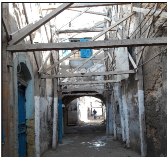
الصورة رقم ( 5 ) العوارض الخشبية التي حلت محل الأقواس في شوارع طرابلس (تصوير الباحث)
