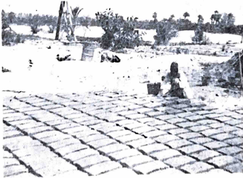
صناعة الطوب التي في واحة الطلاب وذلك لبناء منازل القرى .
