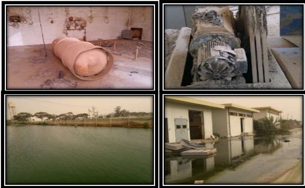
صورة (6) أثار الصدى في معدات محطة المعالجة والطفح مياه الصرف الصحي في المحطة.
