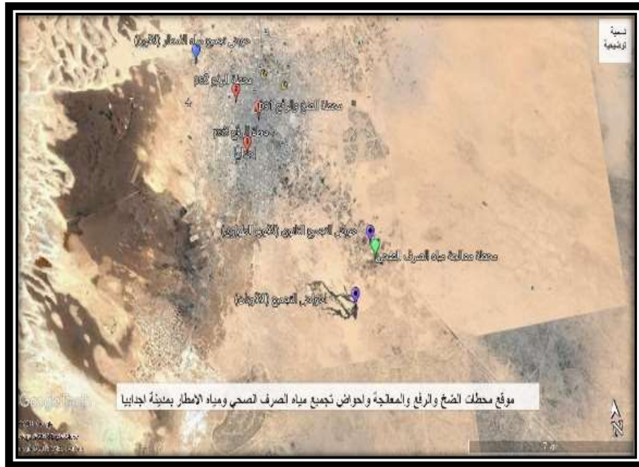
صورة (1) موقع محطة معالجة مياه الصرف الصحي اجدابيا.
