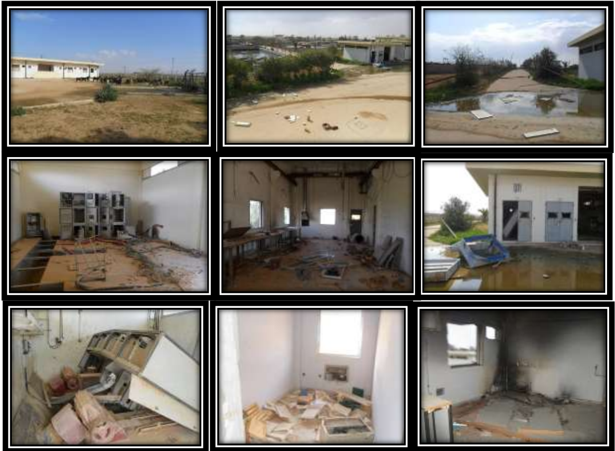
صورة (2) الوضع الراهن في محطة معالجة مياه الصرف الصحي.
