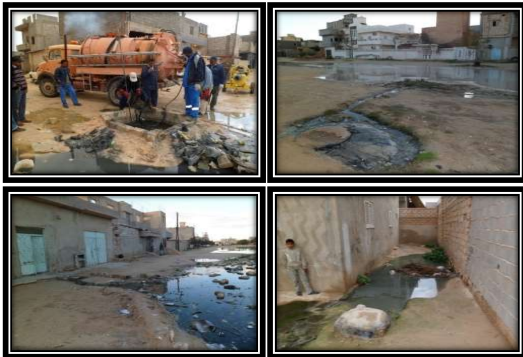
صورة (7) انسداد غرف التفتيش لشبكة الصرف الصحي بالملوثات الصلبة والطفح السطحي لمياه الصرف الصحي المنزلي في شوارع حي الأدغال.
