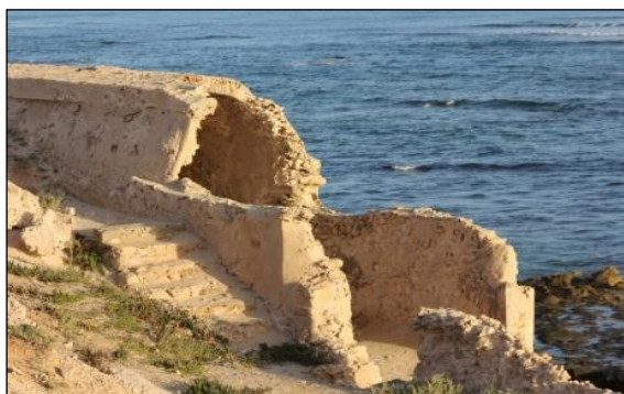
صورة (4) بقايا سلم يربط سطح الفيلا بشاطئ البحر
