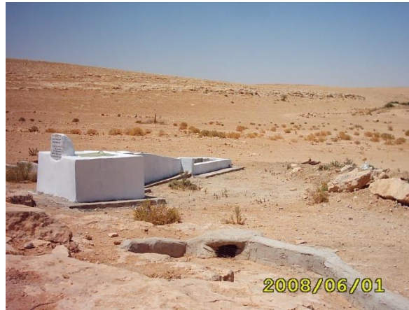
شكل (20) أحد صهاريج المياه القديمة بالمنطقة تم تنظيفها وإصلاحها حديثاً
